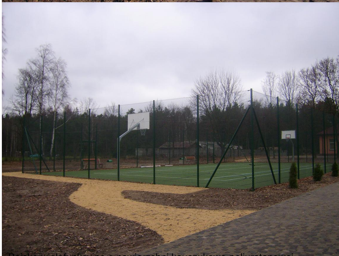
Boisko wielofunkcyjne o nawierzchni kauczukowo-poliuretanowej
